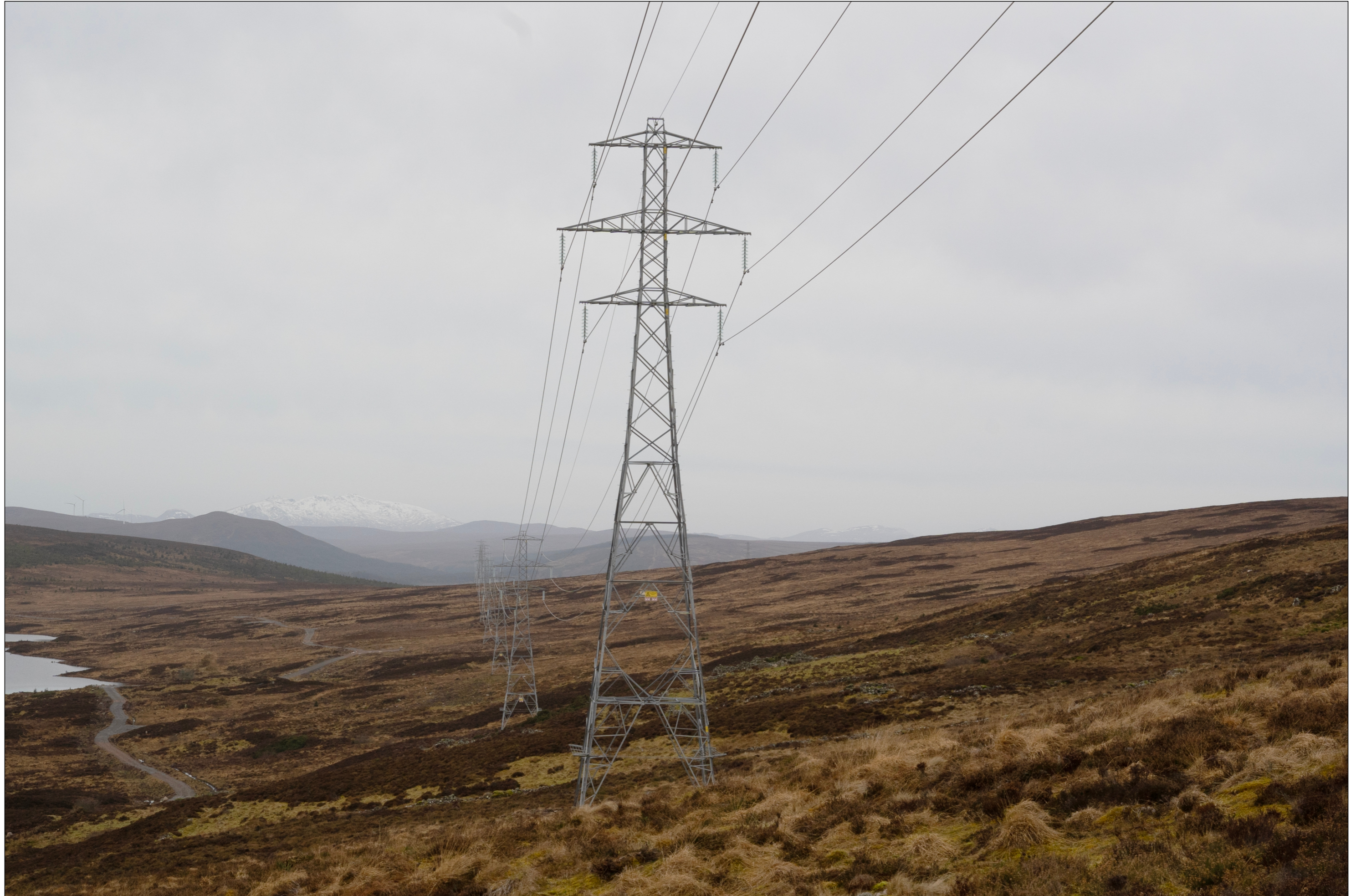
Dalchork (Lairg) - Loch Buidhe - TOWER TYPE - L7C
