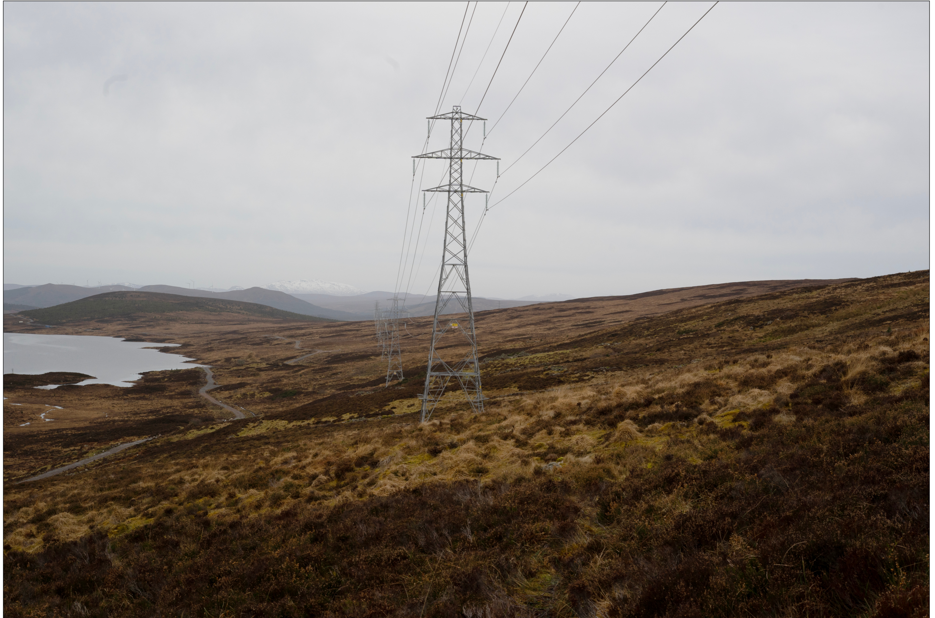
Dalchork (Lairg) - Loch Buidhe - TOWER TYPE - L7C
